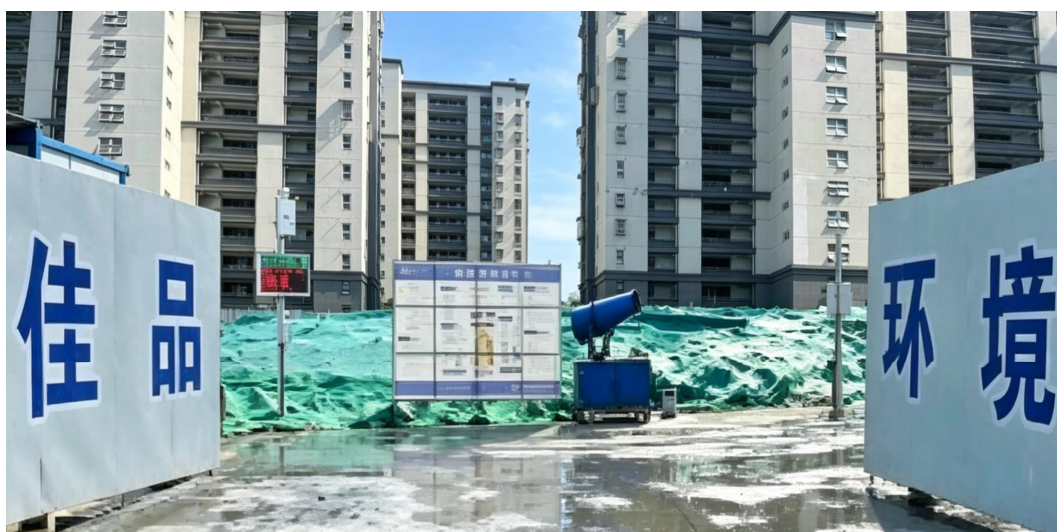
现场封闭围挡及扬尘控制
